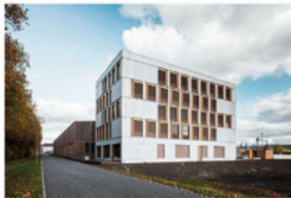
Minergie P- Neubau. Der Heizwärmebedarf beträgt hier nur 15 kWh/m 2 a
