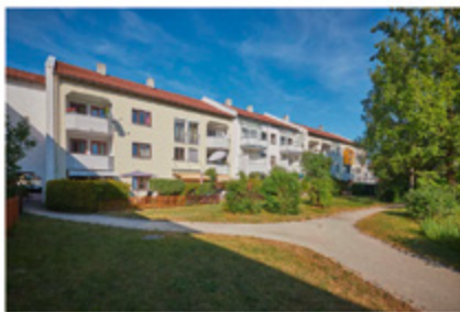
Teilsanierte Liegenschaften auf den 50- Jahren Der Heizwärmebedarf kann hier mit ca. 50 kWh/m 2 angenommen werden
